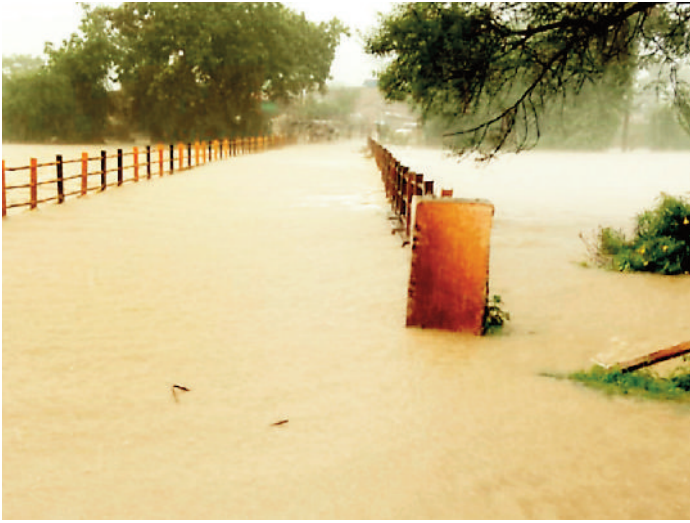
कुटीघाट पुल के ऊपर से चल रहा पानी
